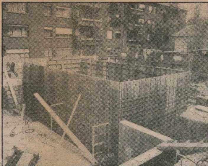
Refugi dissenyat per Antoni Alcahud en fase de construcció
