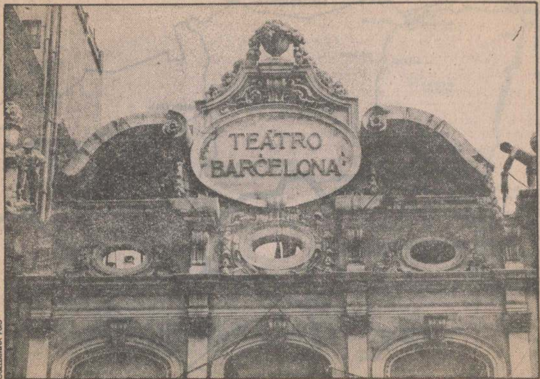
Sobre el veterano teatro Barcelona pesaba un expediente de edificio ruinoso
